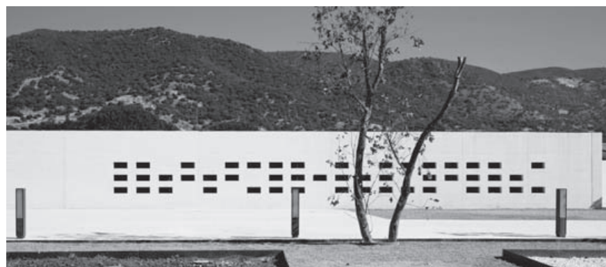
Abb. 3: Die Madinat al Zahra Museum von Sobejano: Einmal fertig gestellt, sieht man das Bauwerk fast nicht in der Landschaft. Nur die Mauern aus
