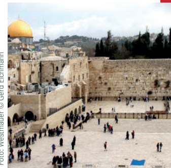
Foto: Westmauer © Gerit Eichmann
