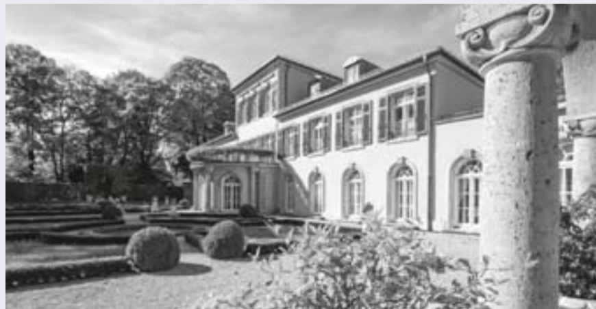
Schloss Suresnes steht im Mittelpunkt des Besucherinteresses beim Tag des Offenen Denkmals.
